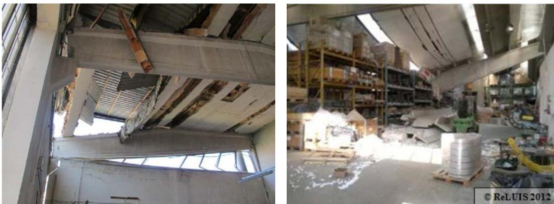
*Figura 1- Collasso di elementi strutturali per perdita di equilibrio durante il sisma del maggio 2012 in Emilia*
